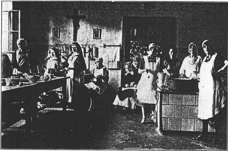
Kuchyně polévkového ústavu v Moravské Ostravě
