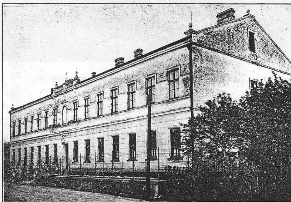
Ústav dominikánek pro slabomyslné v Klimkovicích
